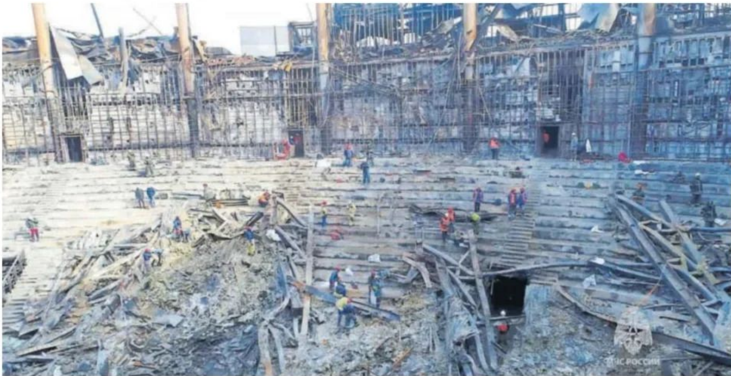
Trabajos de desescombro en el edificio del centro de ocio incendiado en los ataques del viernes 22. REUTERS
