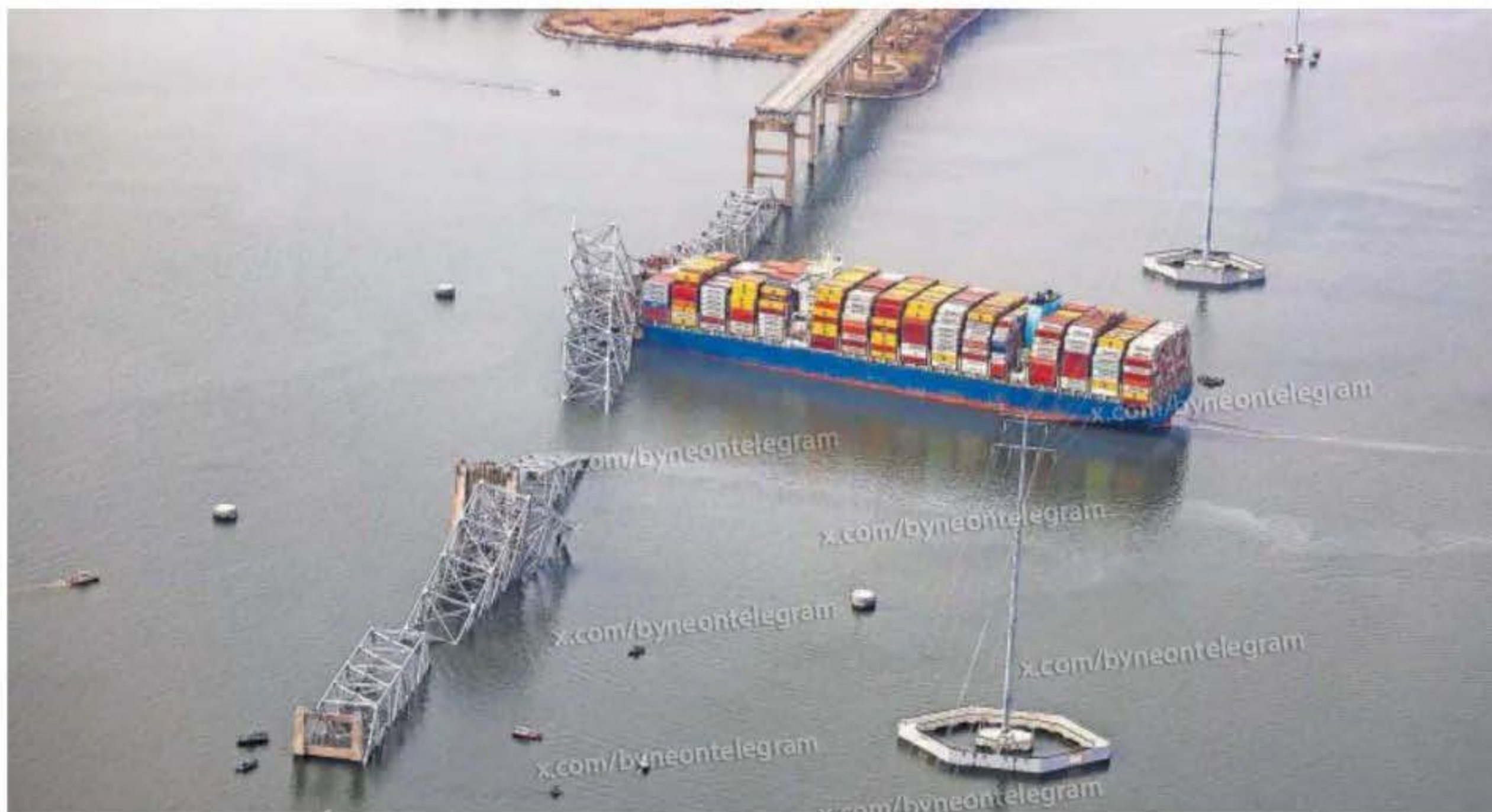
Dramático derrumbe de un puente en EE UU. Un carguero derribó ayer un puente en Baltimore (EE UU). El accidente se produjo cuando el barco perdió el control y chocó con un pilar de la infraestructura, que se desmoronó de inmediato. N. HOWARD (REUTERS) —P3
